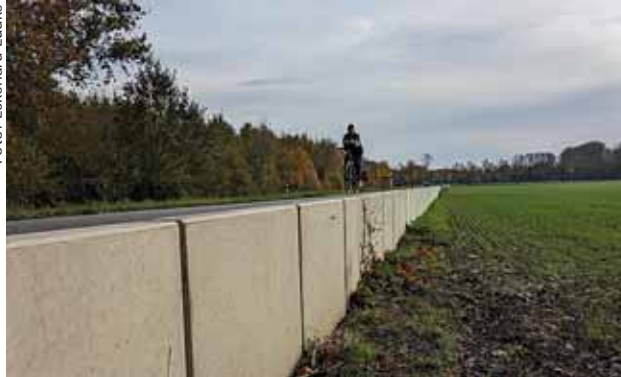
Radweg entlang der K 21, wer hier abstürzt ..
